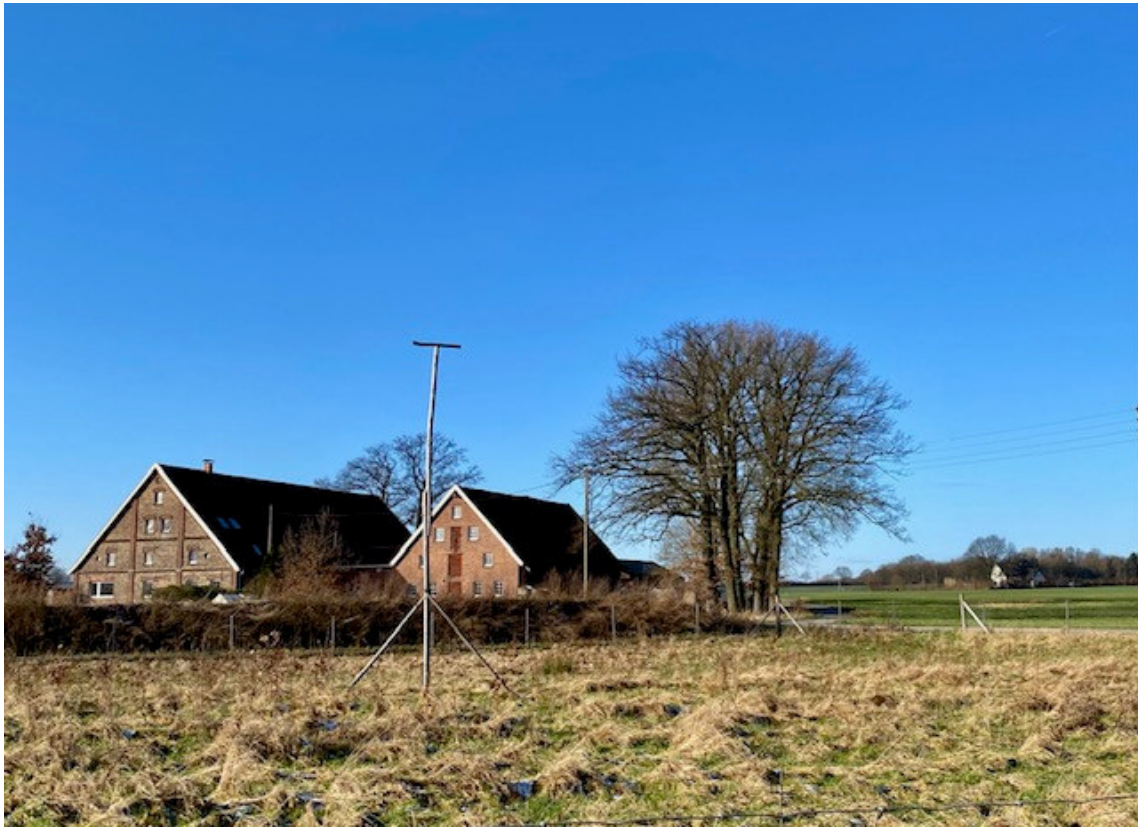
Abb. 2: Hof Hallerberg mit dem früheren Kotten Hallerberg im Hintergrund, Foto Gerlinde Bartels, 2024
