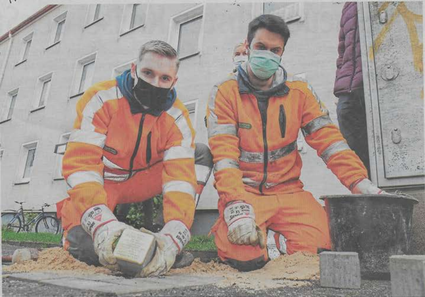
Marcel Mergner und Patrice Hertel (von links) verlegen den Stolperstein für Hedwig Möller an der Straße Kleine Howe 18. Hier lebte die Bielefelderin, bevor sie 1943 wegen einer psychischen Krankheit deportiert und ermordet wurde.
